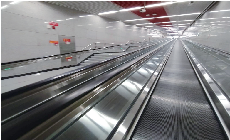
9号线红岩村地铁站电梯
