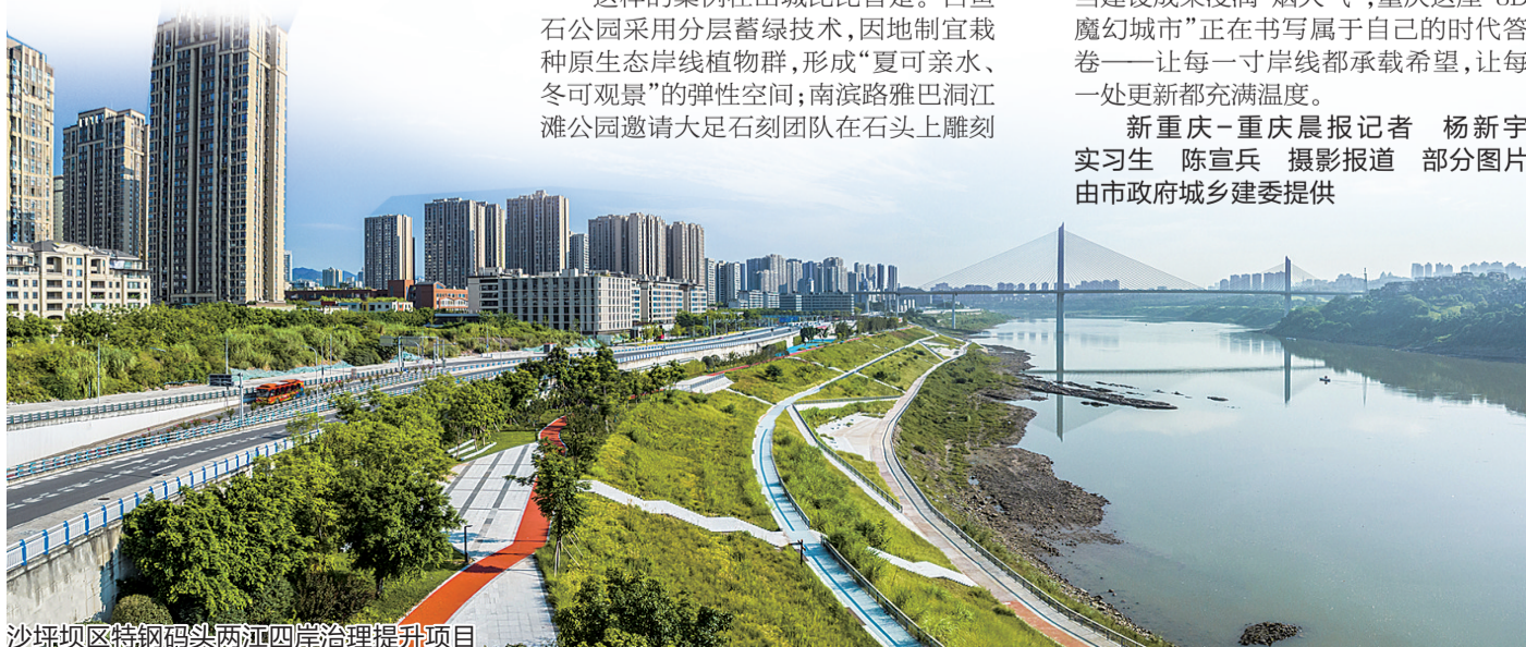
沙坪坝区特钢码头两江四岸治理提升项目
