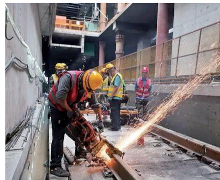
施工现场，工人对钢轨头进行无缝焊接。
