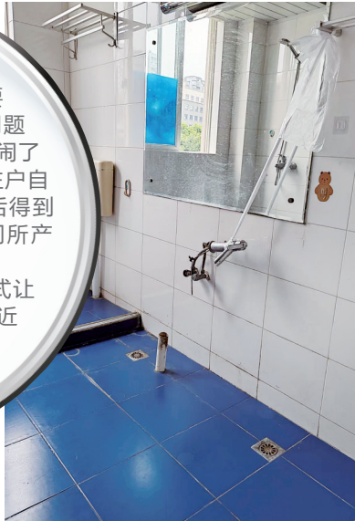
卢先生拆除洁具的卫生间
