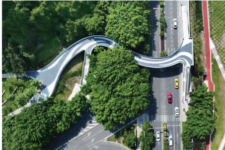
渝中区化龙桥滨江岸线过街天桥即将竣工
