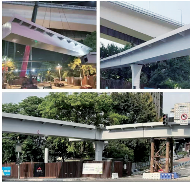
江北嘴金融中心配套基础设施工程(二期)建设现场
