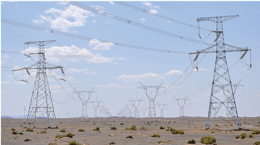
哈密—重庆±800千伏特高压直流输电配套线路
