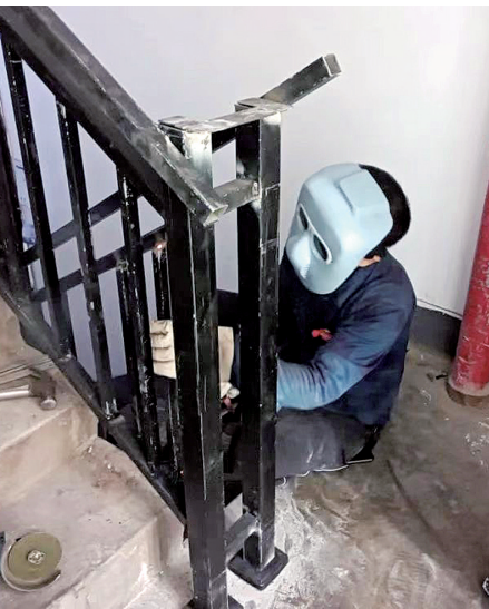
兴隆苑片区老旧小区改造项目建设现场 新重庆-重庆晨报记者 杨新宇 摄影报道
