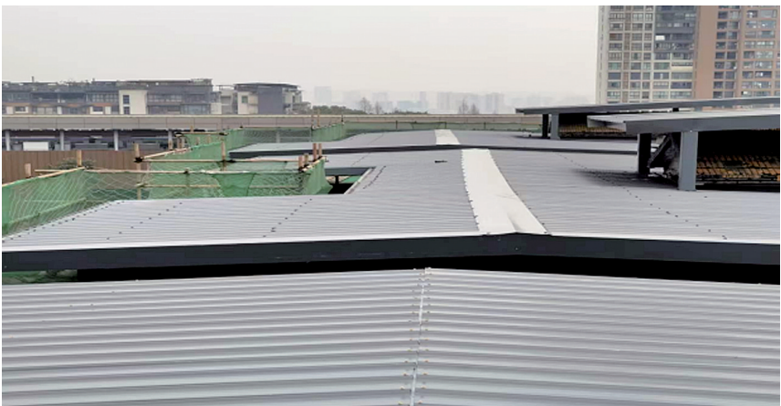
楼顶整治,居民不用担心房顶漏水了。
