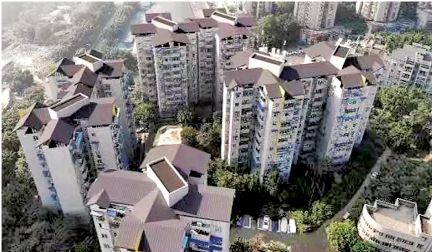
惠丰居小区改造项目
