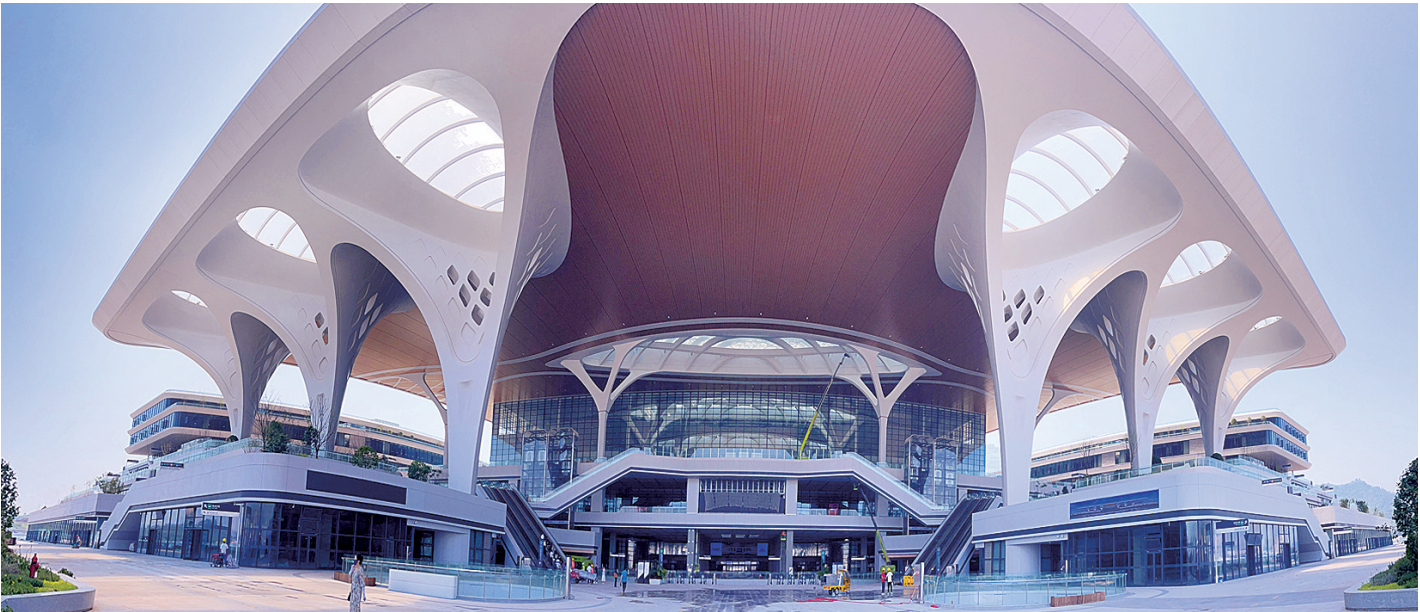
我国西部地区目前在建的最大高铁枢纽站——重庆东站
