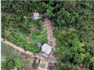
彭水郁山镇白池村发生局部滑塌
