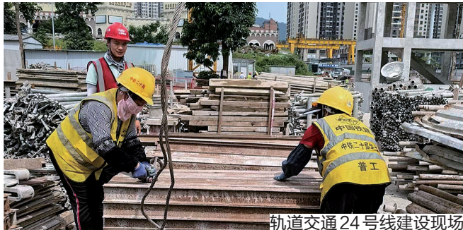
轨道交通24号线建设现场
