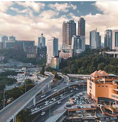
菜园坝火车站前的立交桥
