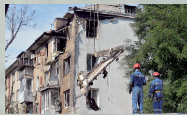
救援人员拆除受损的居民楼
