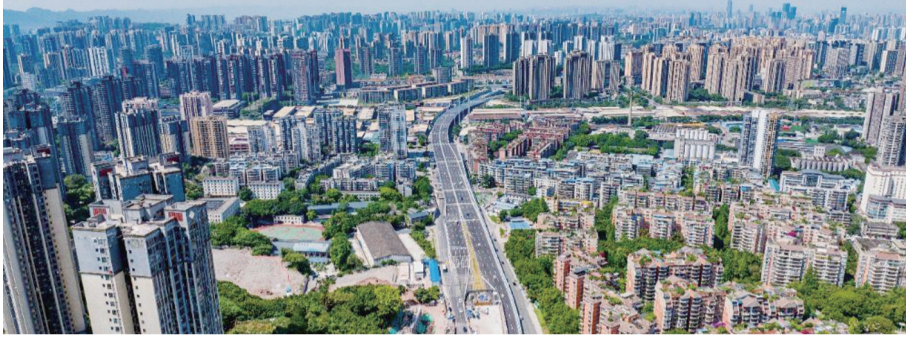
2025年5月12日,大渡口区双山隧道至五台山立交段改造项目临时通车,极大减缓该区域交通压力。 据新重庆-重庆日报
