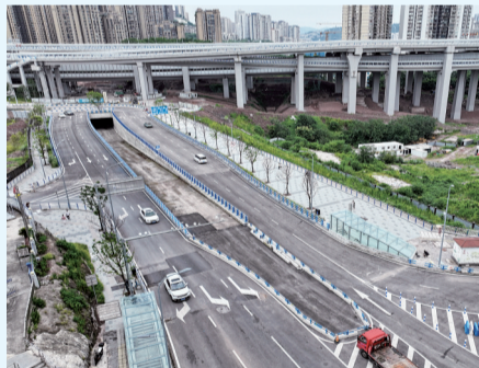
7月20日下午3点,红岩村嘉陵江大 桥北桥头建新西路四期前卫厂段(203中 学段)匝道通车。
