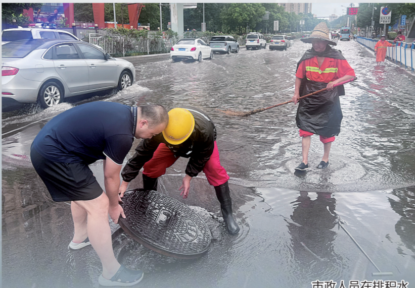
市政人员在排积水
