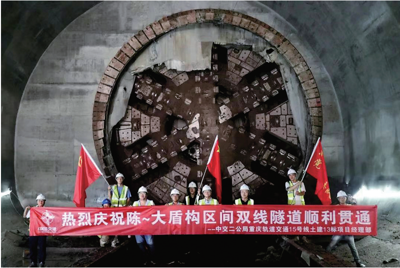
轨道交通15号线二期陈家桥站至重庆电子科技职业大学站区间左线贯通
