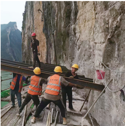
工人们在搭建悬挑脚手架
