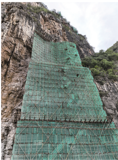
吊嘴岩正在治理
