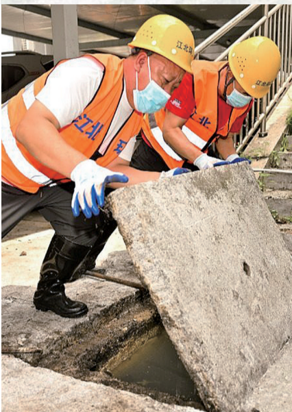
8月7日,江北区,市政工人冒着高温奋力顶开厚重的下水道井盖。 据新重庆-重庆日报
