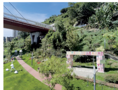
项目位于轨道环线大桥旁
