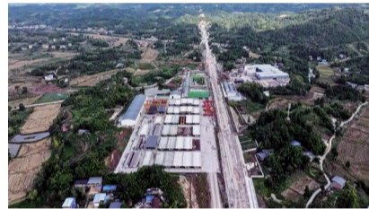
建设中的成达万高铁开江南站
