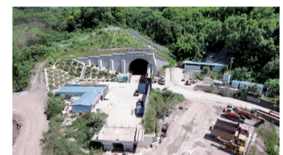
高粱乡隧道施工现场
