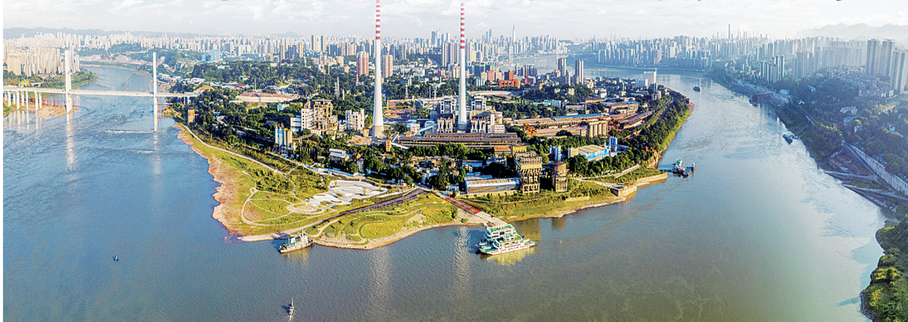
“两江四岸”治理提升九龙半岛段项目
