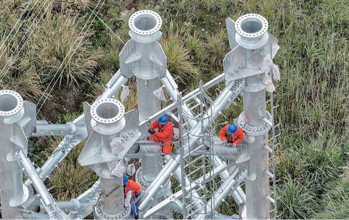
金山——明月山500千伏线路31号塔施工现场
