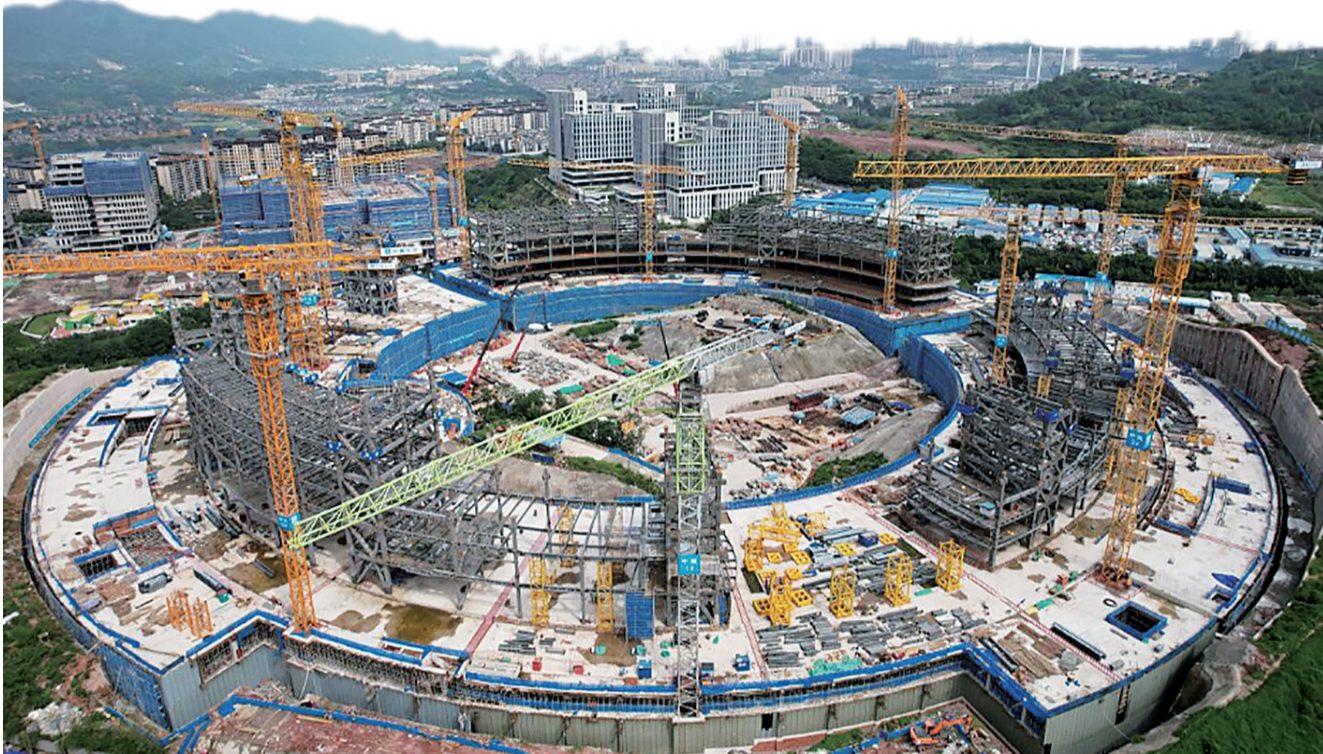
两江新区产业发展集团有限公司A09—2、A09—5号地块项目
