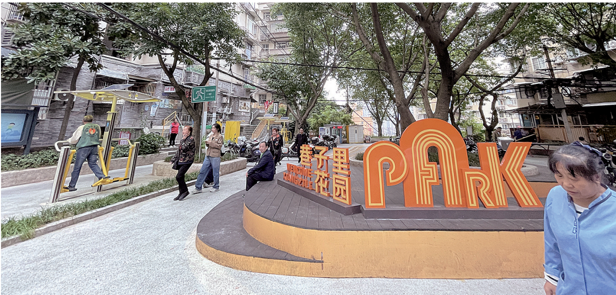
项目拆除片区违章建筑，充分利用闲置废弃空间，为居民“挤”出了1000多平方米的公共休闲空间，打造出一个巷子里的“花园”。
