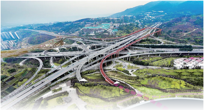
黄桷湾立交改造工程
