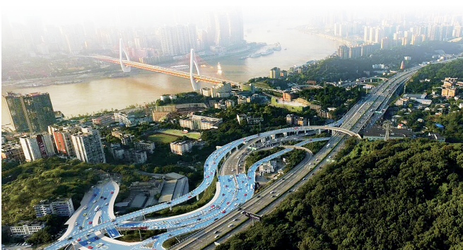
南山立交改造工程
