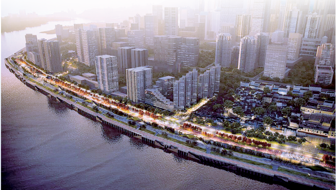
长滨片区道路下穿工程
