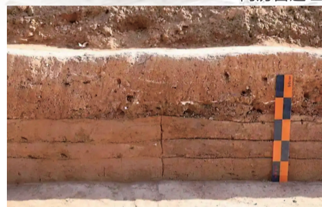
TG20中段夯土1、2分界线(东—西)
