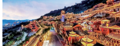
万州天生城片区综合提质改造项目
