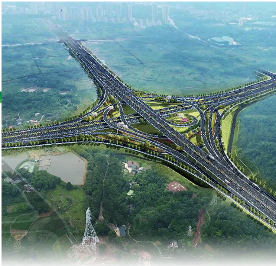
一纵线农马立交至白彭路立交段二期
