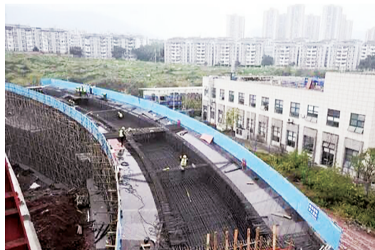
渝长高速复线连接道工程施工现场
