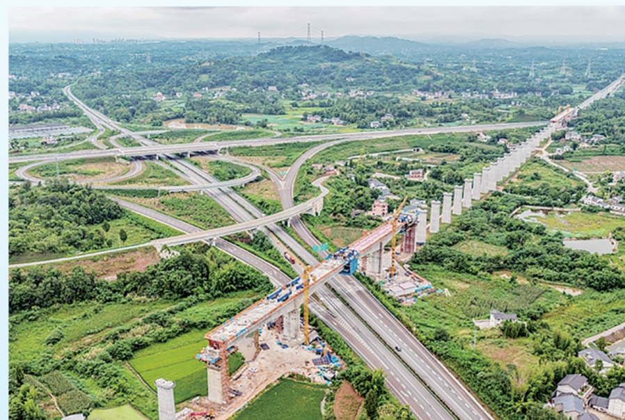
成渝中线高铁互通双线特大桥梁建设现场
