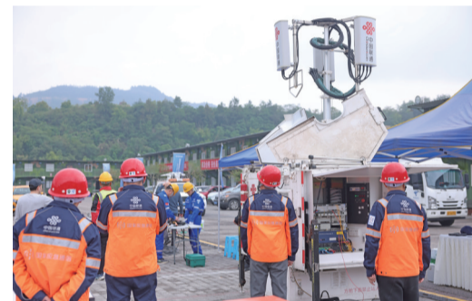
重庆联通某产业园区网络建设施工现场
