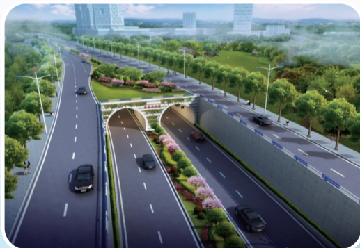
龙兴片区新建下穿隧道
