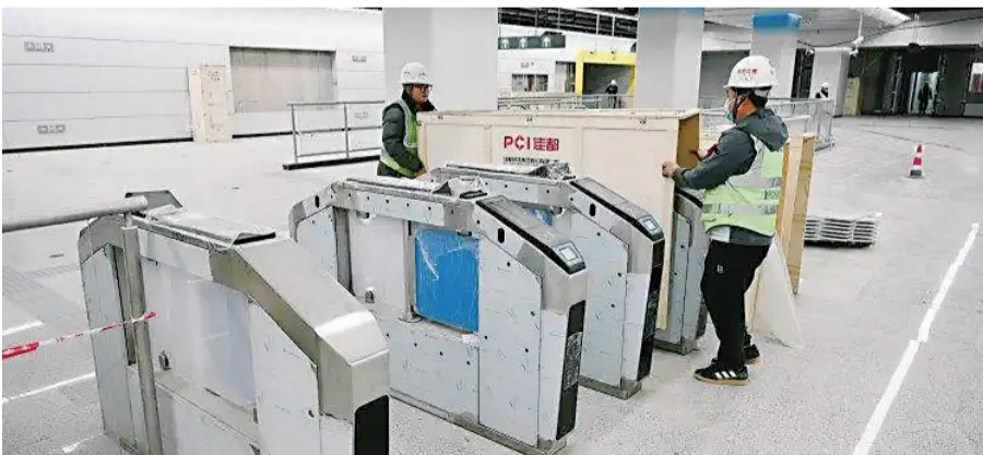
15号线福惠大道站建设现场
