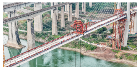
成渝中线高铁井口嘉陵江特大桥建设现场
