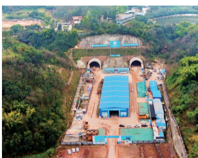
樵坪山主线隧道
