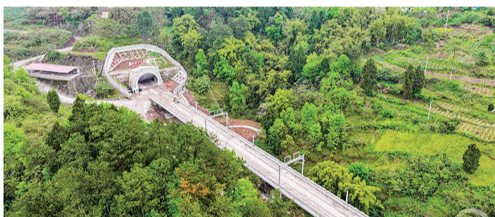
建设中的新渝万高铁
