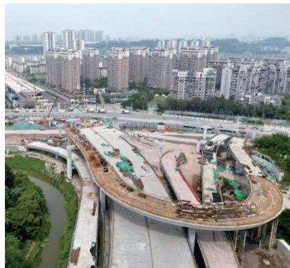
新燕尾山隧道二标段项目苦竹坝段
