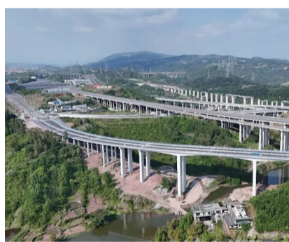
两江新区水土新城太山二路大桥及连接道主体工程已完工
