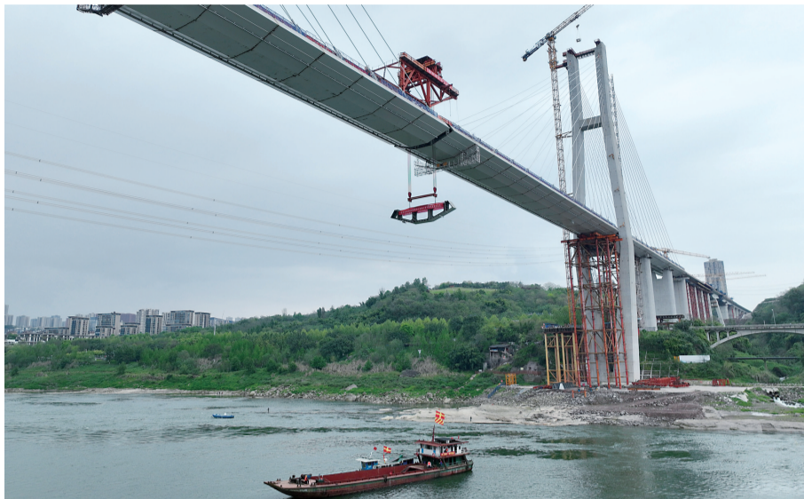
成渝中线高铁井口嘉陵江特大桥正在进行最后一节钢箱合龙段的吊装
