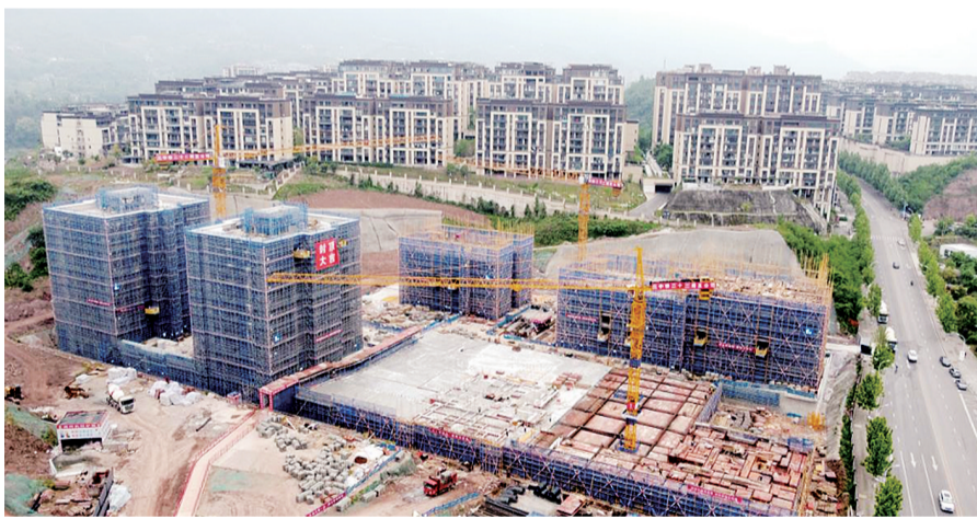
北碚区I10-02/05地块保障性住房项目
