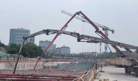
轨道交通7号线物流园枢纽站至物流园北站区间大里程明挖段主体结构顺利封顶
