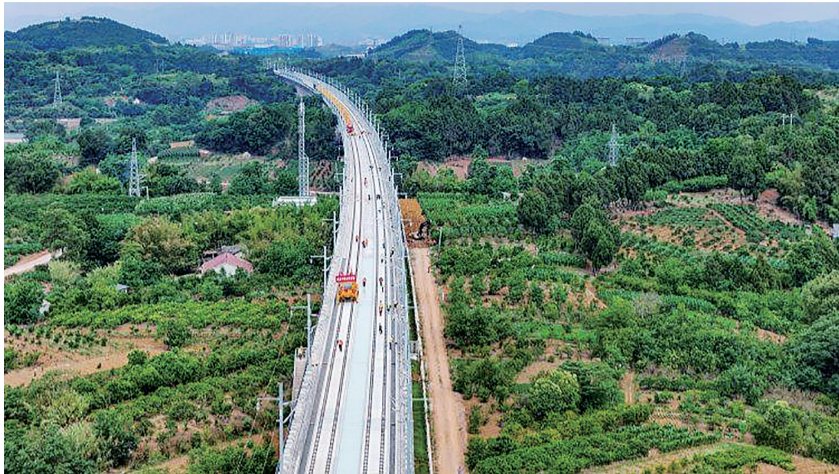
成渝中线高铁全线铺轨工程启动
