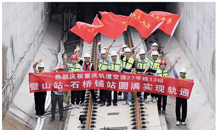
5月30日,轨道交通27号线璧山站至石桥铺站区间率先完成铺轨、实现“轨通”。
