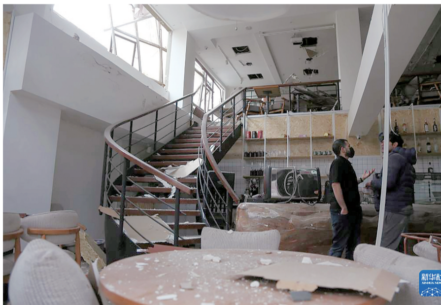
伊朗首都德黑兰一处受损的建筑 新华社发
