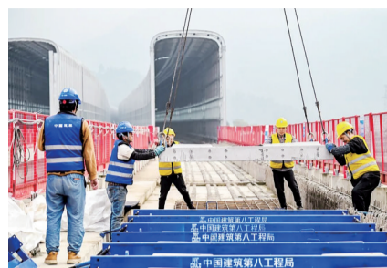
27号线，工人合力完成预制轨道板安装。
