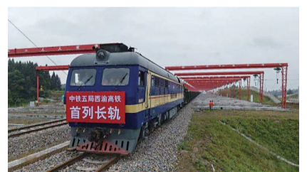
西渝高铁康渝段首列500米长钢轨进场
