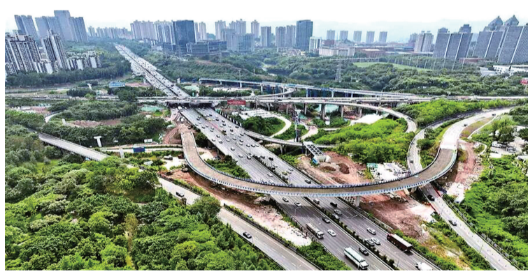
北环立交改造工程新建的首条匝道启动路面铺筑
