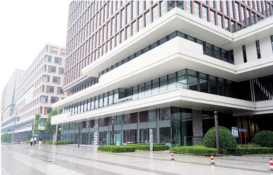
7月底,拼多多雄安公司全员将搬入新办公楼。 李峰摄
