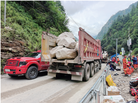
用于填充被冲毁路基的石方陆续抵达
