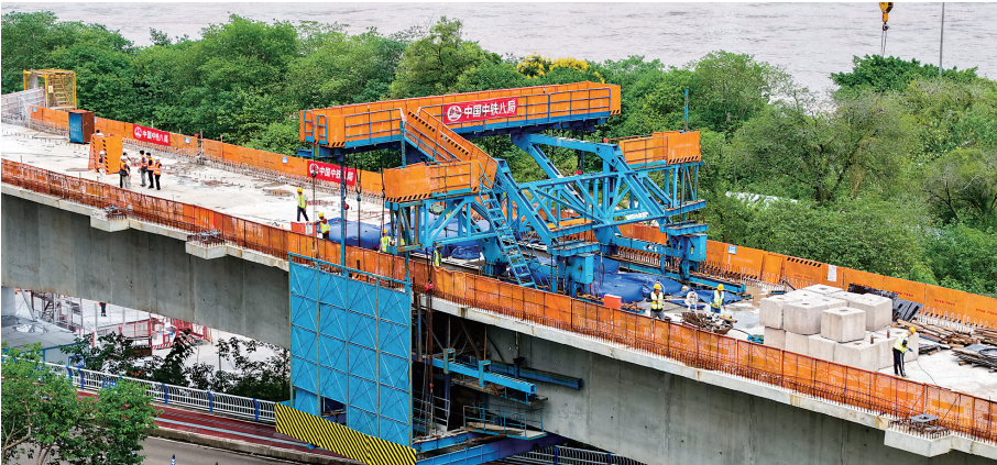
成渝铁路改造工程黄桷坪双线特大桥建设施工现场 新华社发
