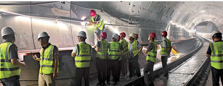
各单位正在对轨道交通18号线北延工程的疏散施工样板进行验收
